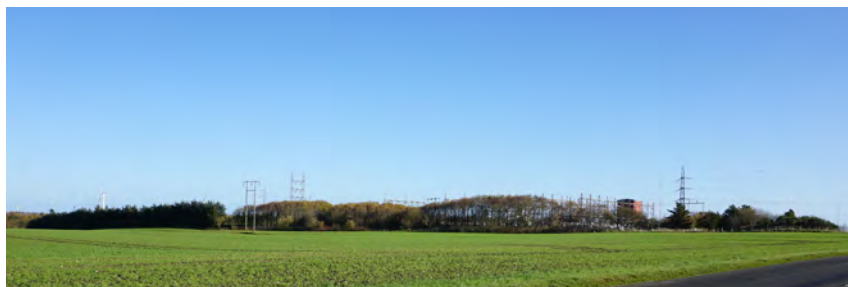
Ved Videbæk ligger en transformerstation, hvor fire højspændingsledninger udløber fra.
