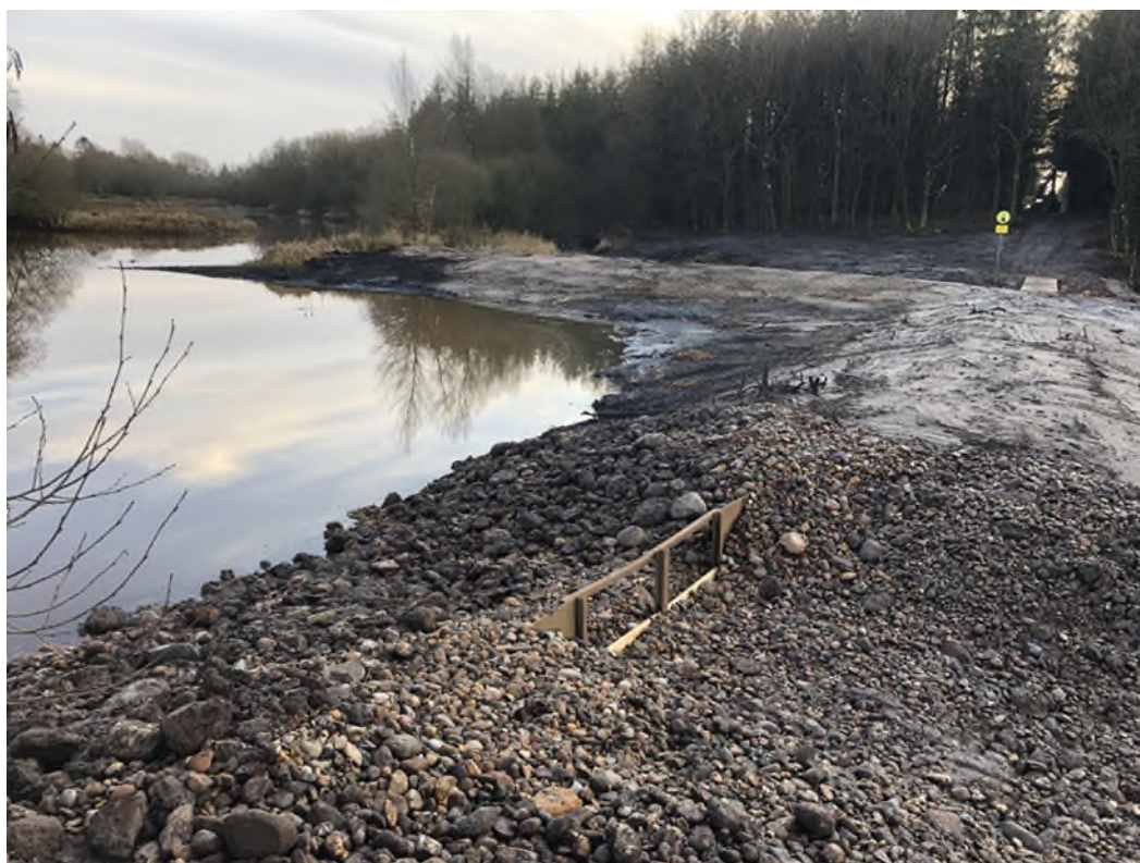
Færdigt stryg-omløb set fra nordsiden af eks. dæmningsanlæg
