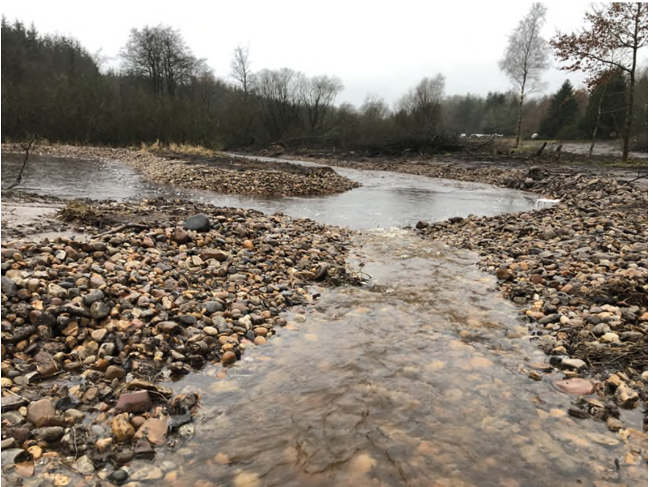
Stryget er færdigetableret og der er igen afløb fra søen
